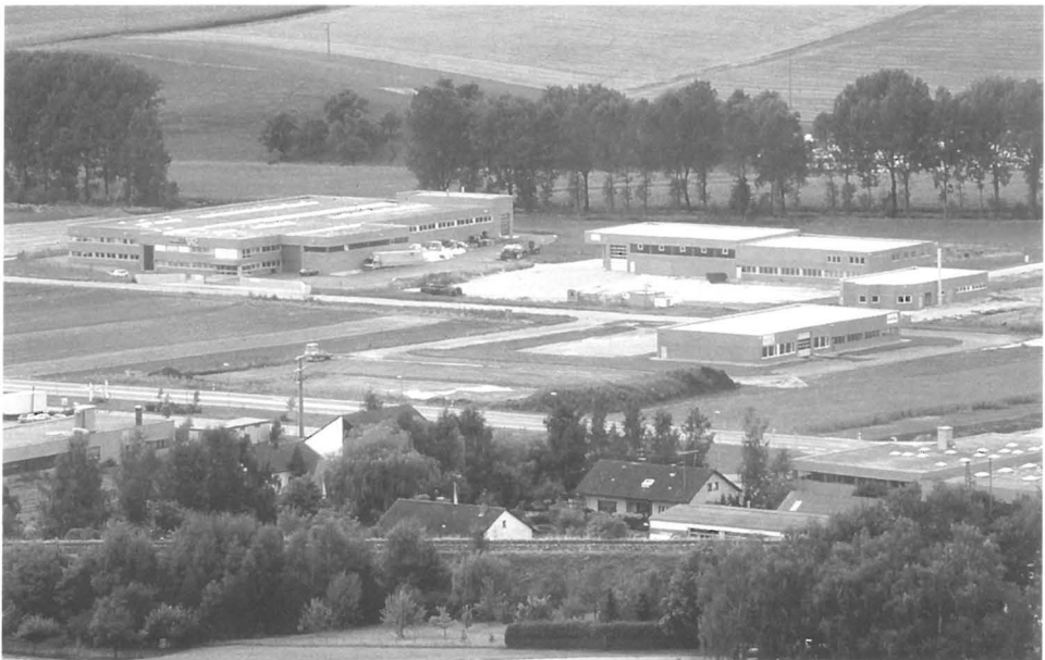
Der im Aufbau befindliche Gewerbehof.
